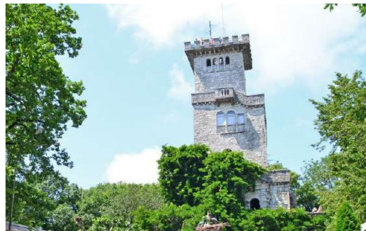
Смотровая башня на горе Ахун
